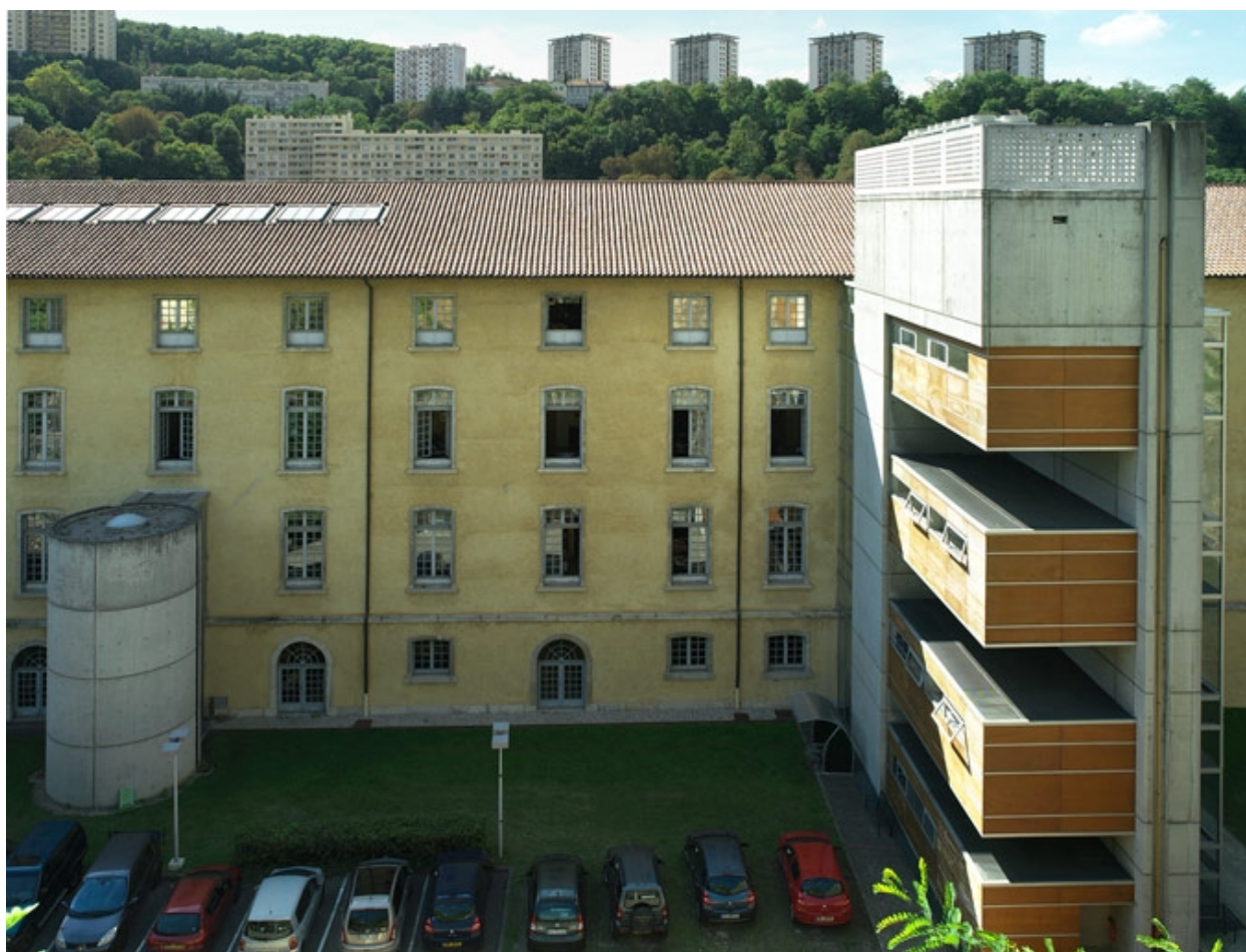
Vue d'ensemble est
