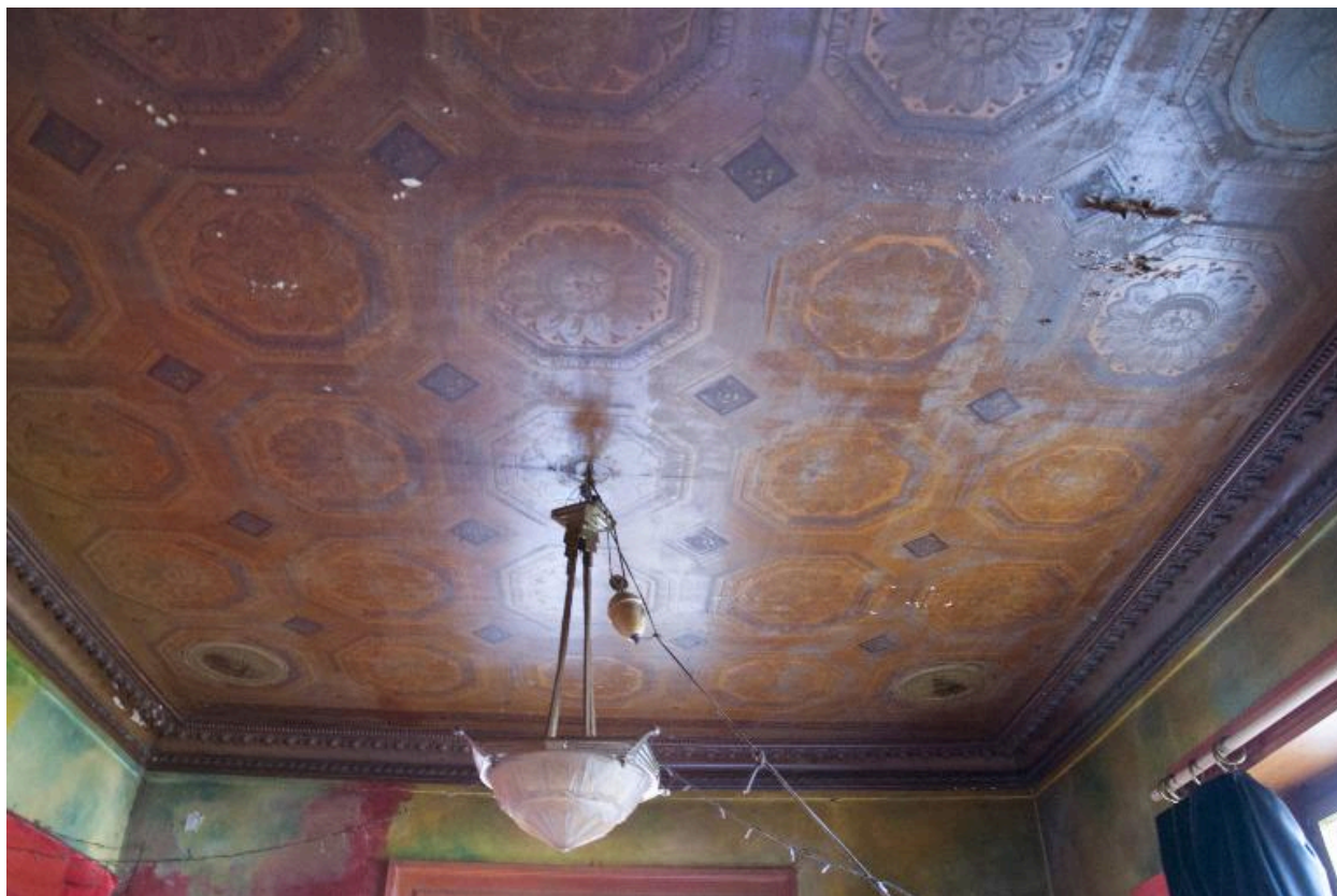
Plafond peint, pièce attenante au vestibule
