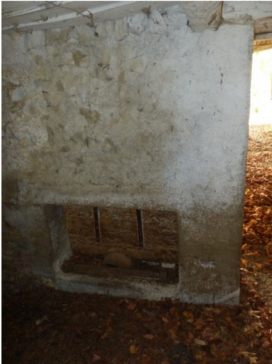
Volet d'auge dans une étable à cochon, entrepôt agricole au hameau du Moulin.
