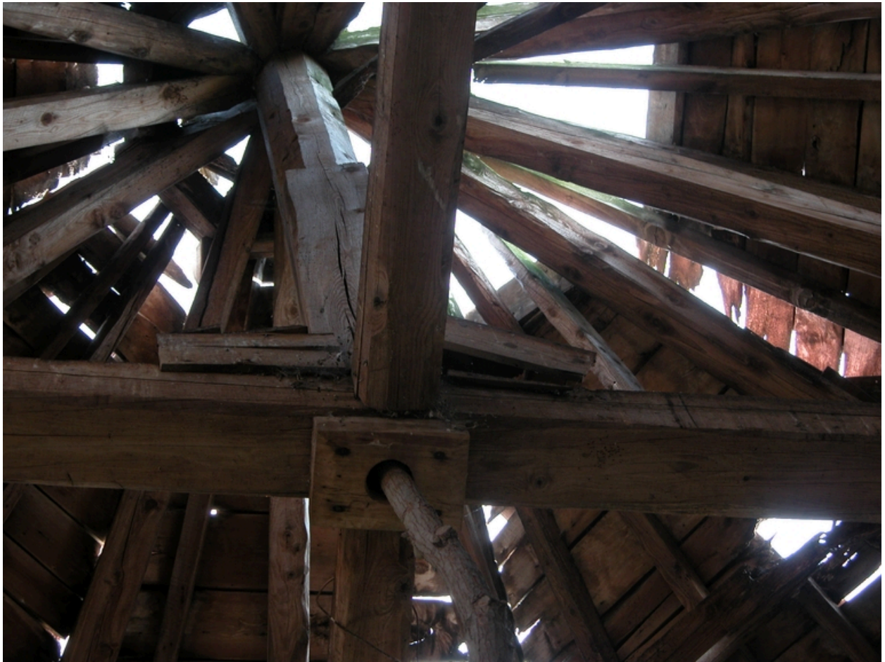
Vue intérieure du pigeonnier : la charpente.
