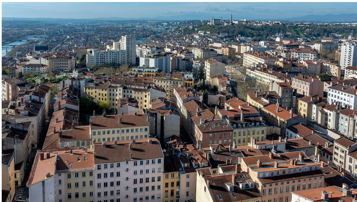
Vue d'ensemble secteur des immeubles-ateliers (vue drone)
