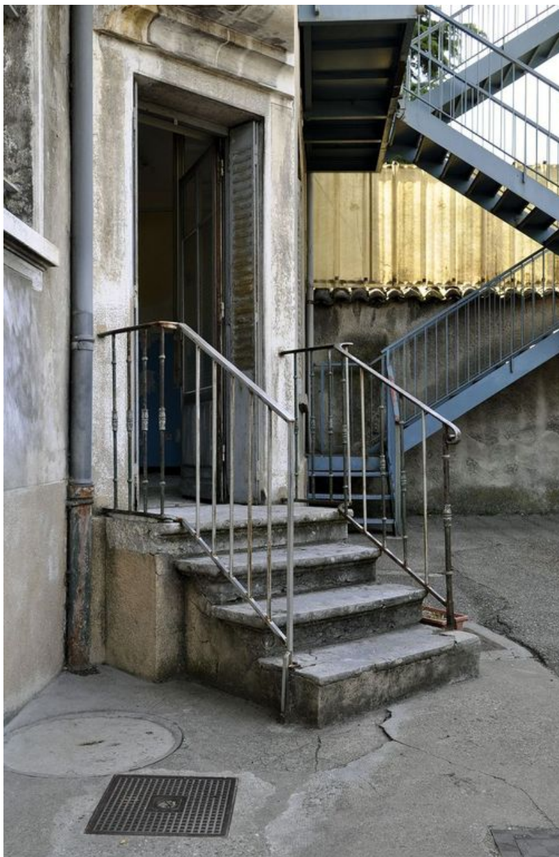
Façade arrière, escalier
