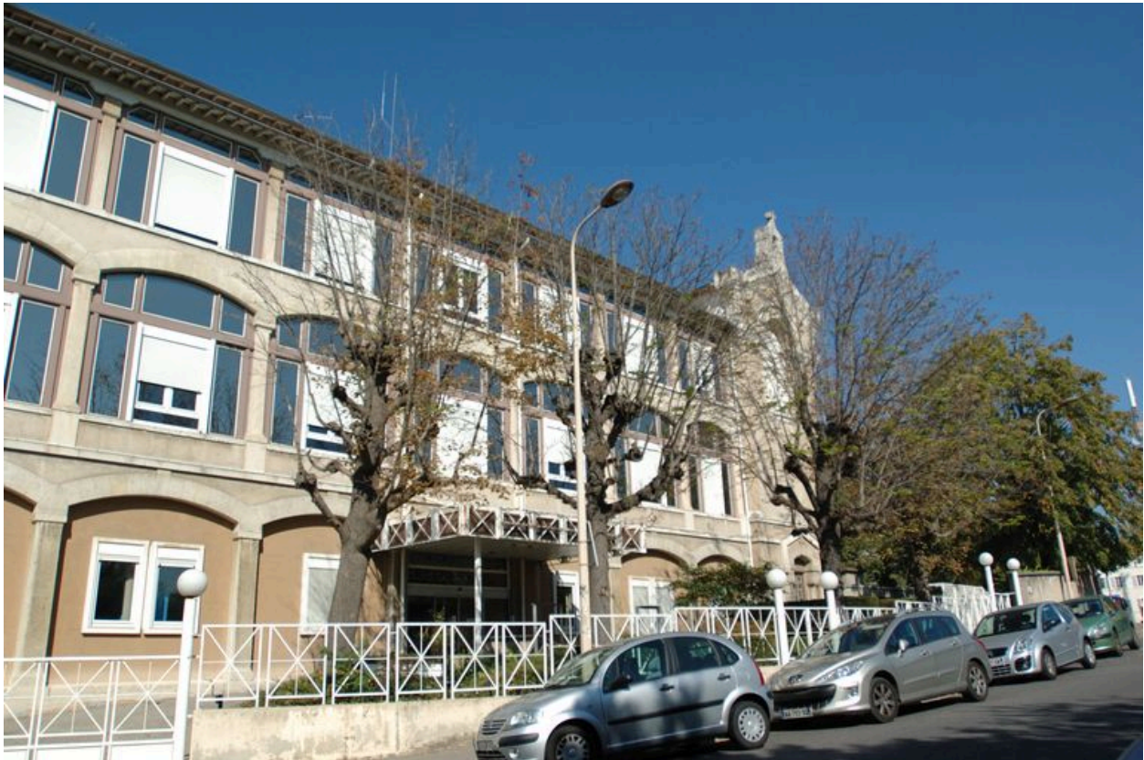
Vue de l'ancien bâtiment des malades, depuis la rue Radisson (élévation est), en octobre 2011.
