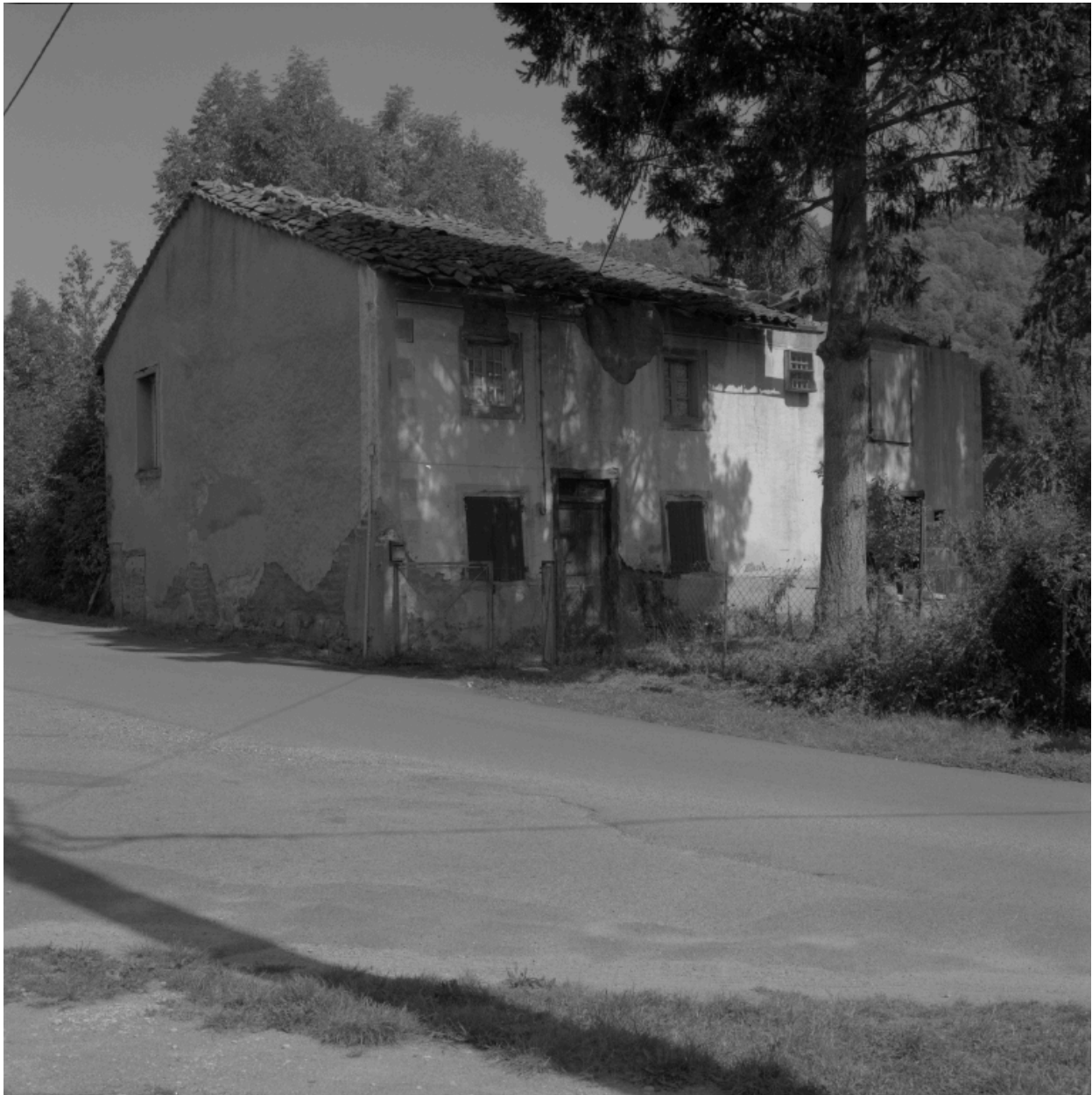
Débats-Rivière-d'Orpra, le Pras (1987 A1 352a), type A1. Vue d'ensemble de la ferme depuis la route.
