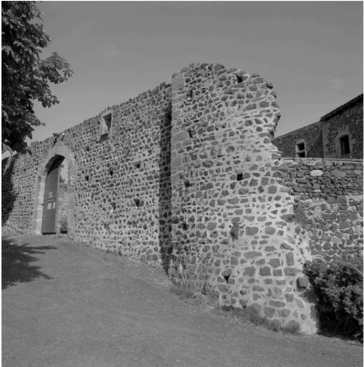
Courtine et tour sud-ouest.
