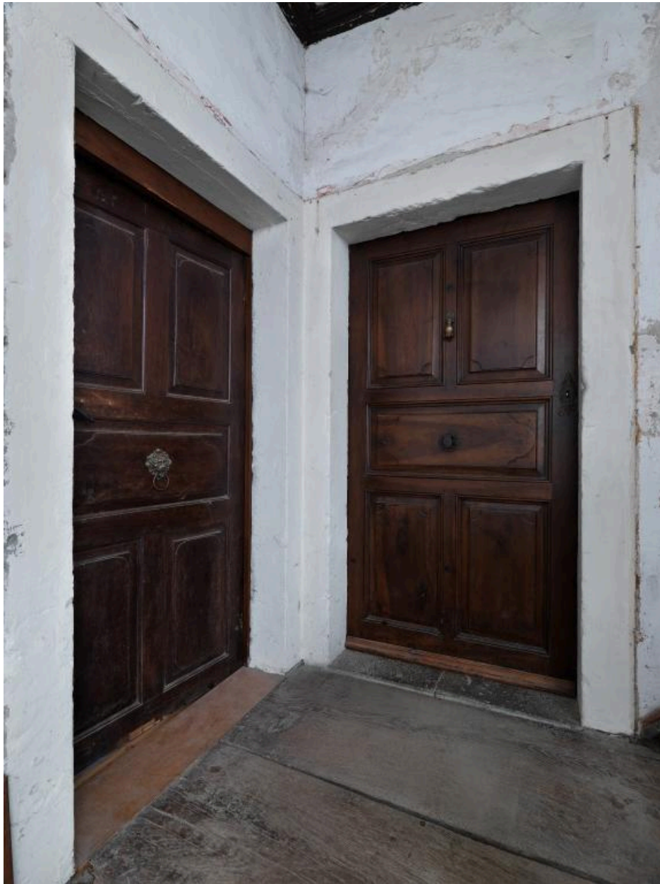
Vue intérieure : portes du palier du 1er étage.
