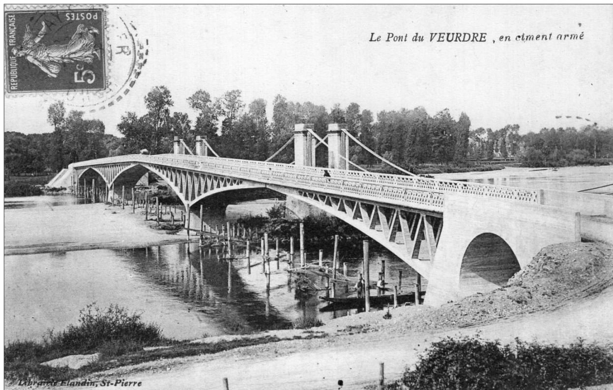
Le nouveau pont du Veudre (n°2) en béton armé et l'ancien pont à l'arrière plan. Vers 1910-1911.
