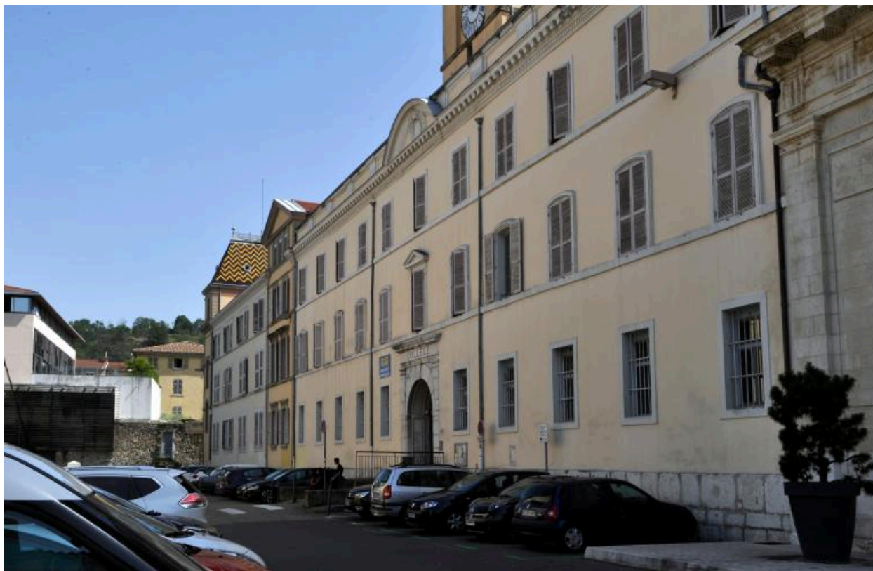
Elévation principale, depuis le sud-ouest
