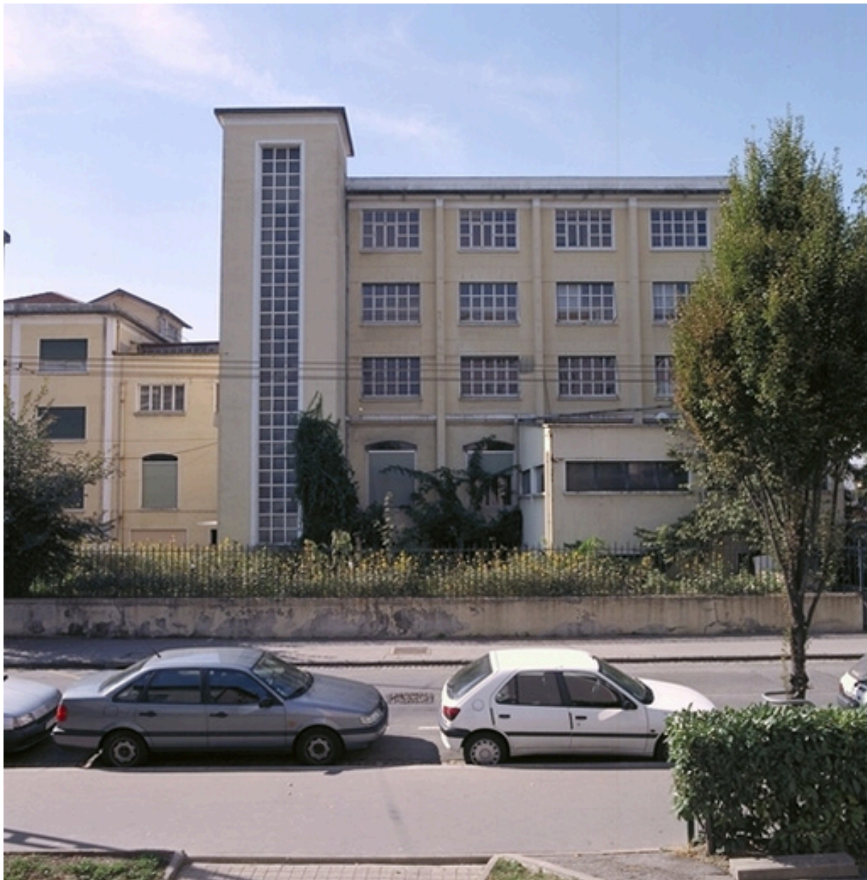
Vue générale est
