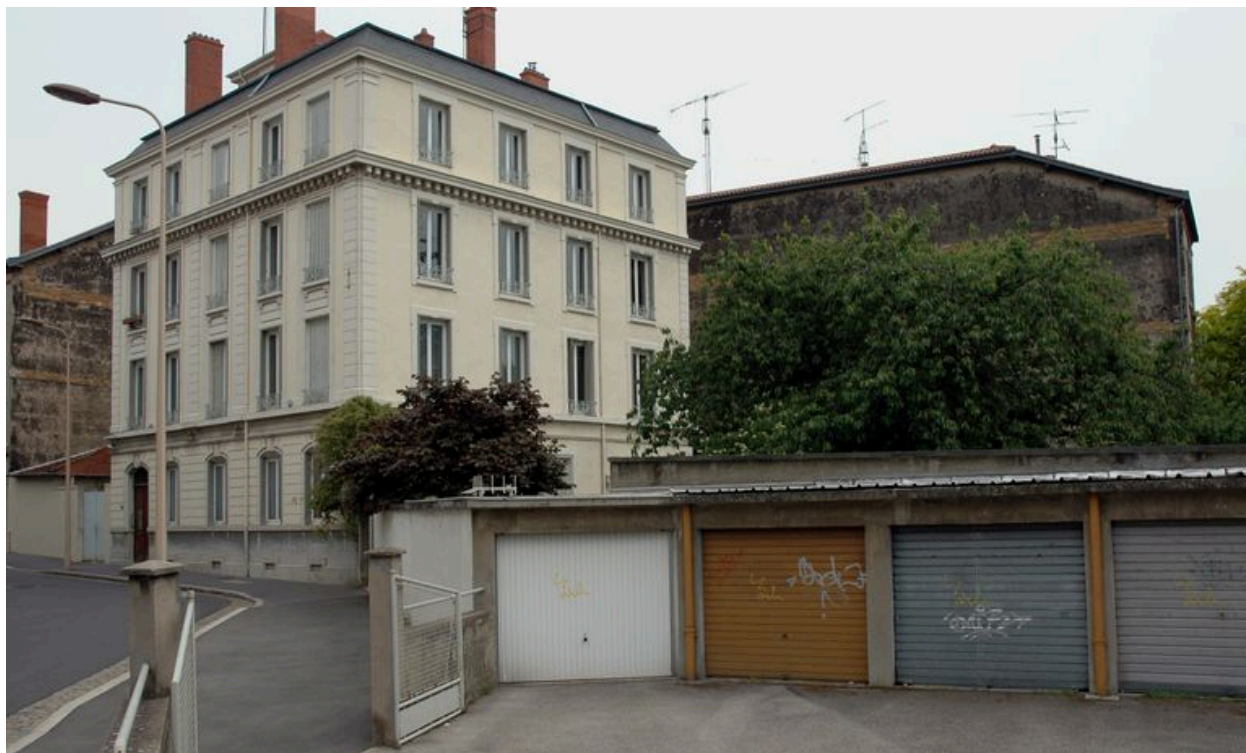
Bâtiment de la galerie, vue de l'élévation postérieure, avec l'immeuble Bouchaudy au premier plan (27 rue Roger-Radisson)
