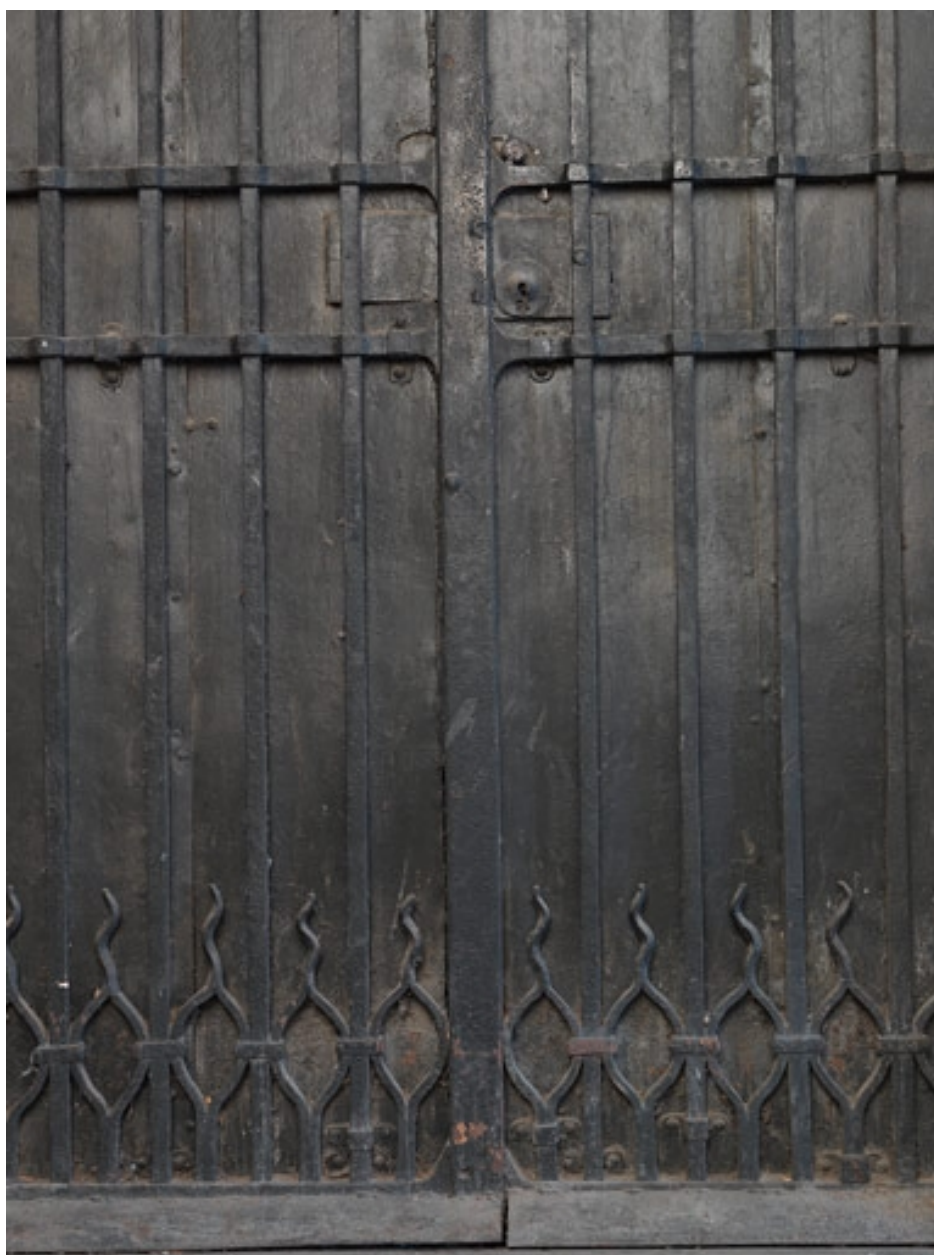
Bâtiment R. La porte métallique vers la cour de la Cuisine. Détail de la grille
