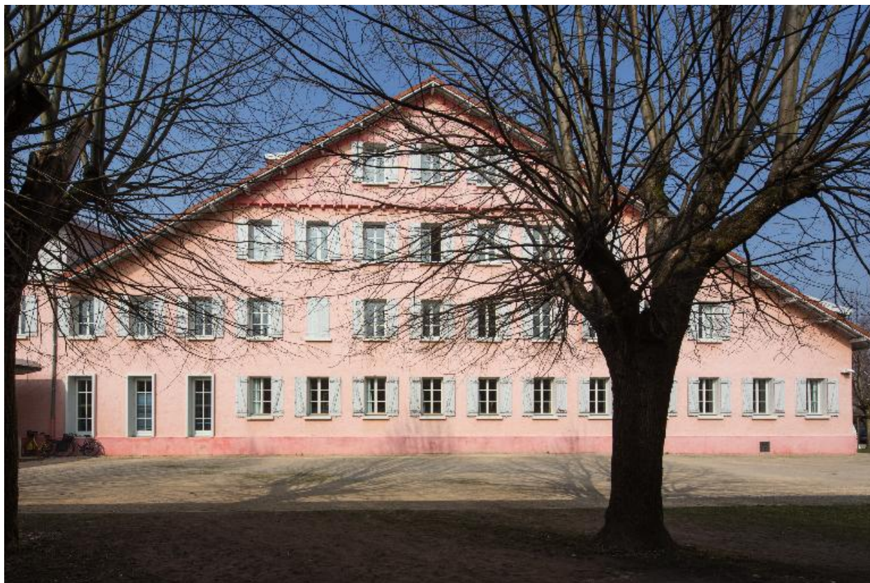
Bât. A : façade nord-est de l'aile est
