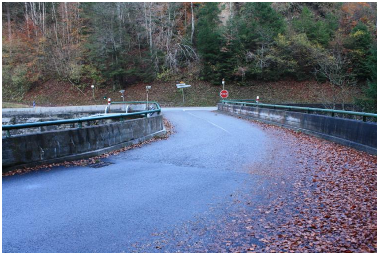
Pont de la Besentière, chaussée et gardes corps
