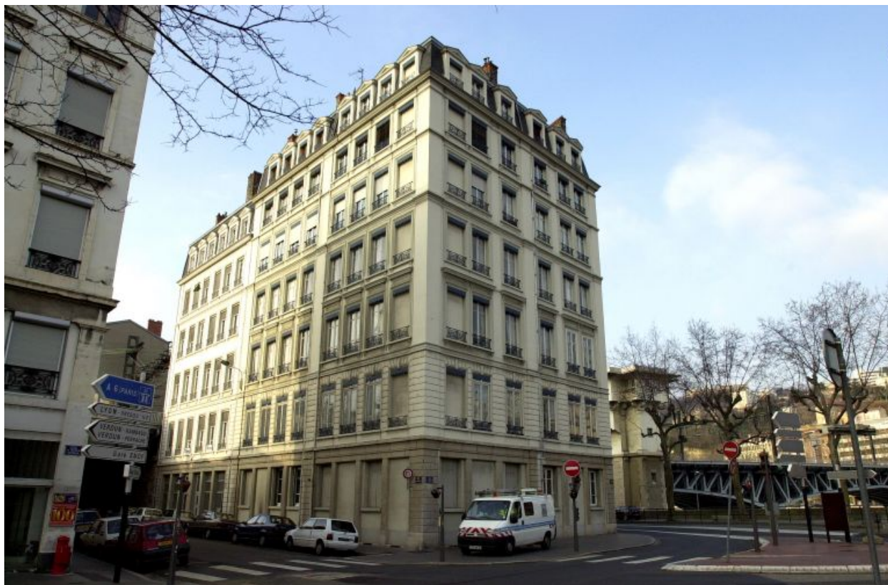
Vue générale depuis le cours de Verdun-Rambaud
