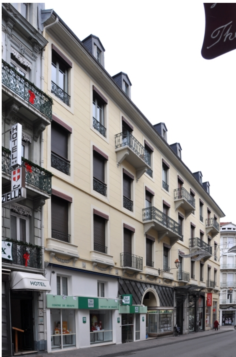
Corps principal : façade sur la rue du Casino
