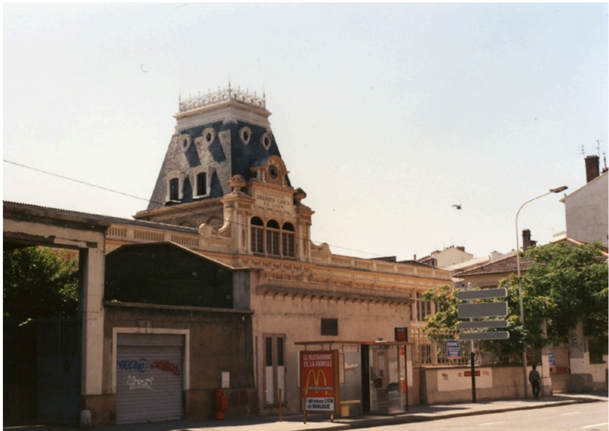
Vue sud-est du site avant démolition (vers 1995)
