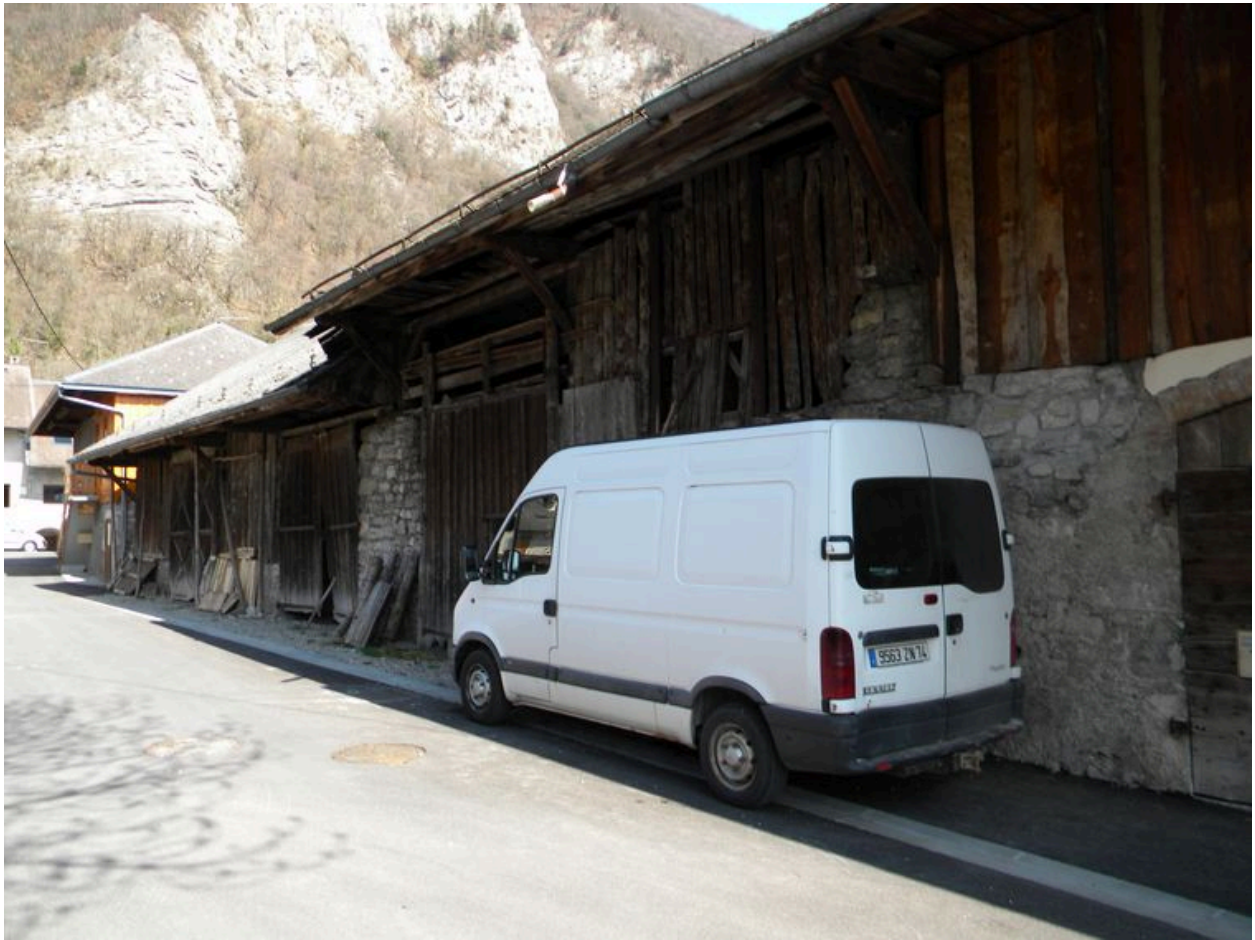
Alignement de façades de bâtiments agricoles vue depuis le sud. (B7 1268, 1269, 1270, 1271, 1272, 2012).
