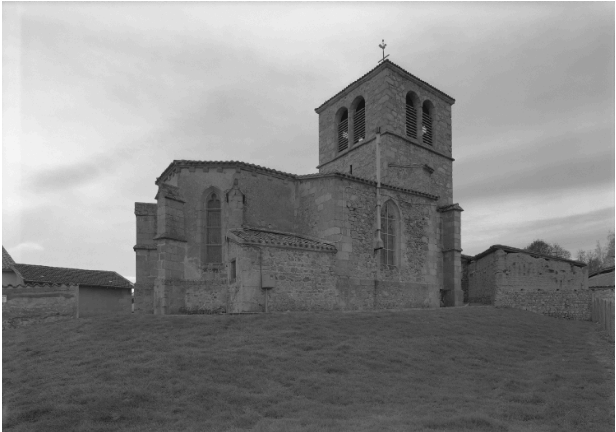
Vue d'ensemble de l'église paroissiale depuis le nord-est.
