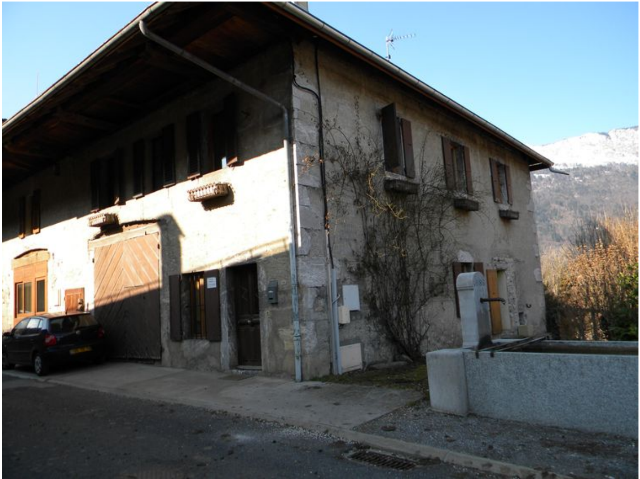
Vue de trois quart de la partie nord.
