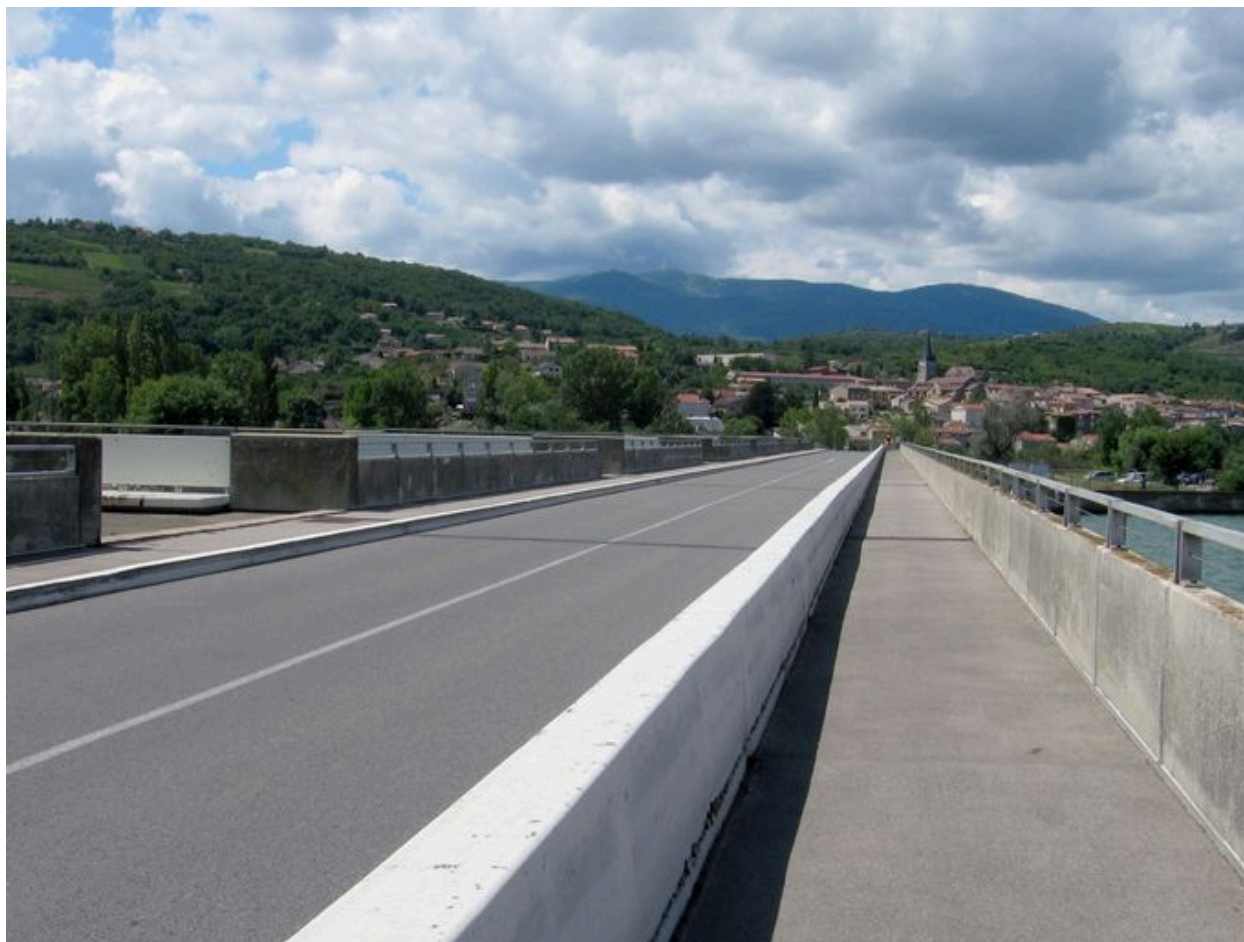
Pont routier, vue partielle : chaussée (depuis la rive gauche)
