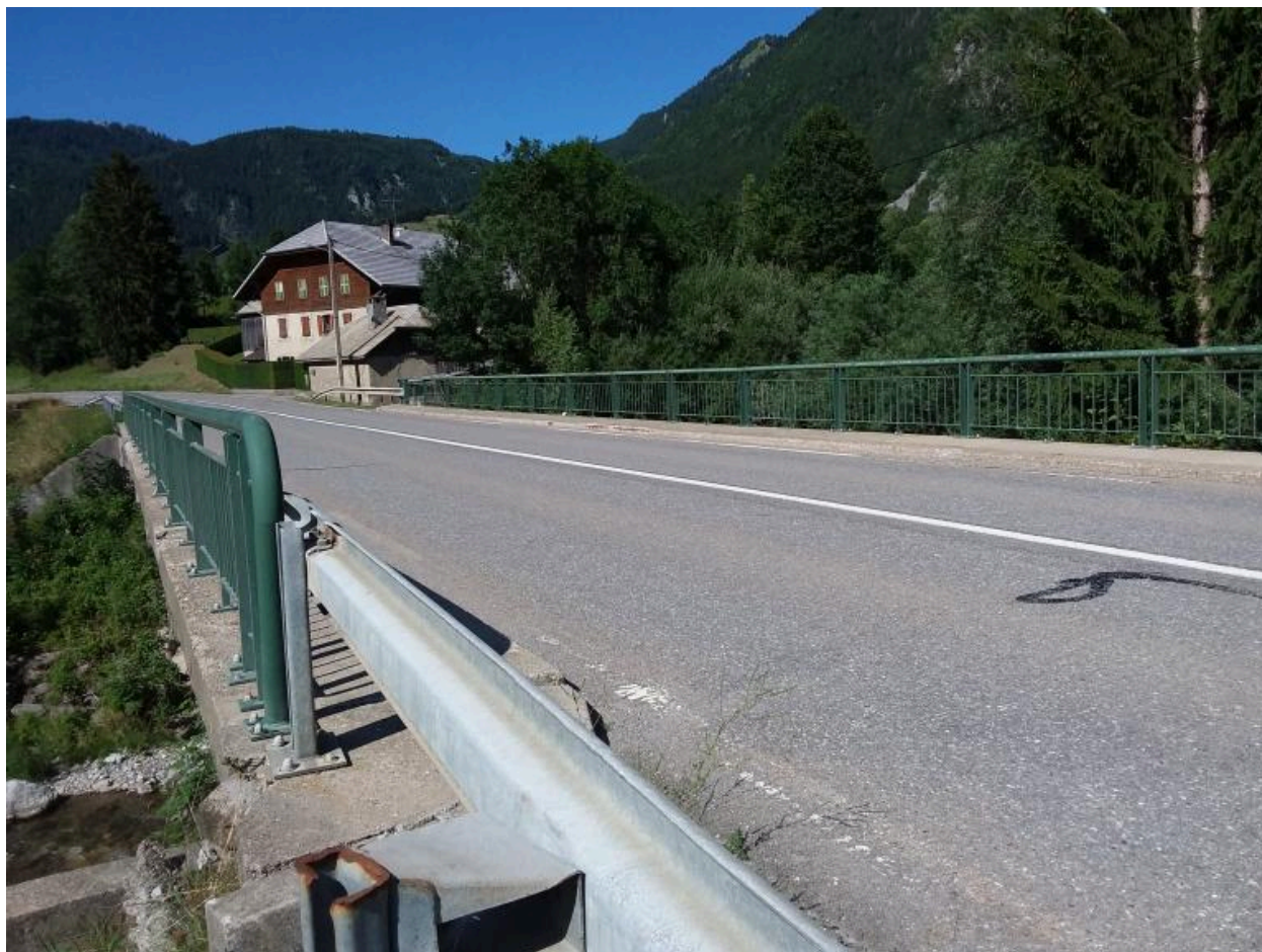
Pont de Vers l'Usine, chaussée et garde-corps
