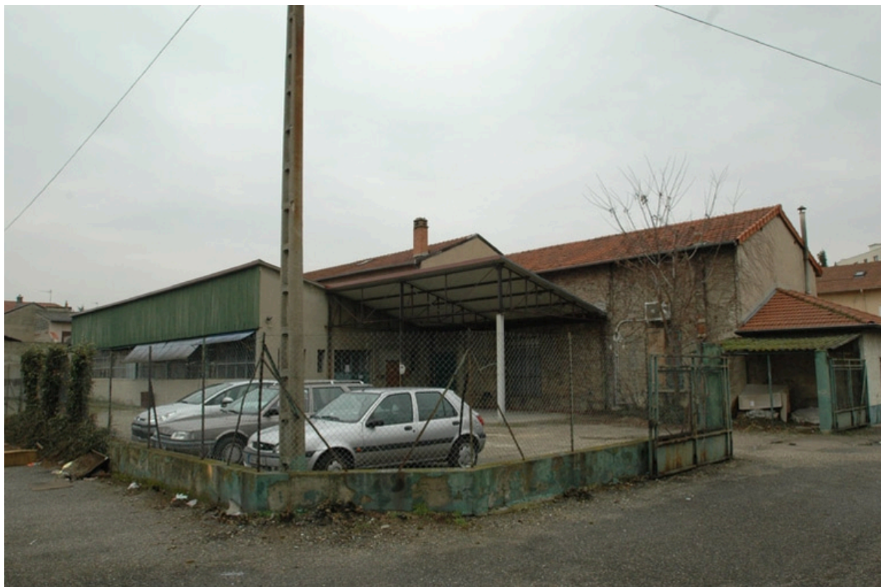
Vue sur cour, façade arrière des entrepôts et hangars.
