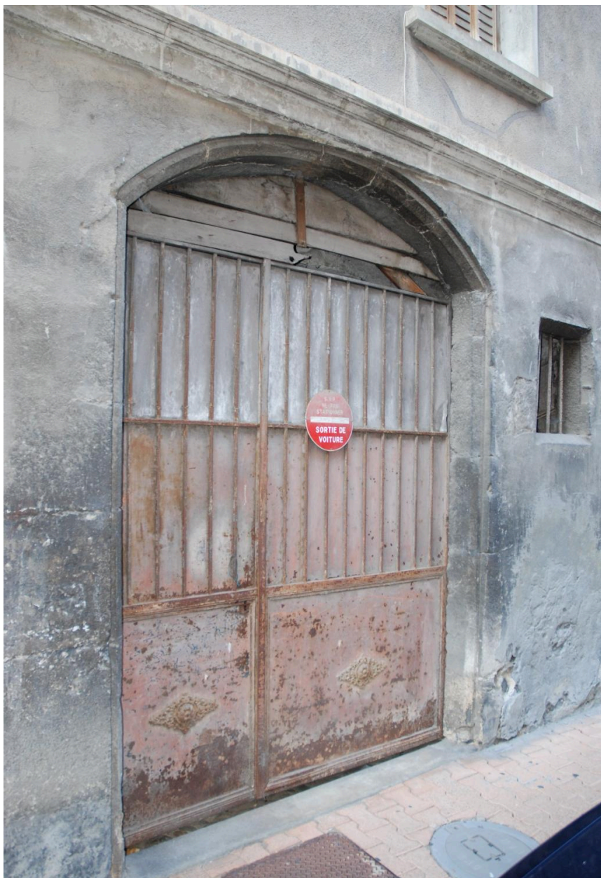
Elévation sur rue de la pension de famille, détail de la porte cochère.
