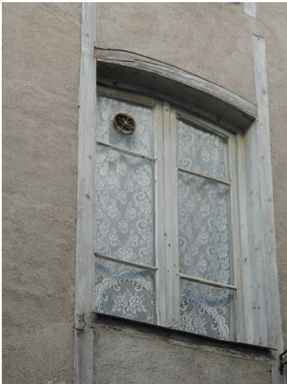
Fenêtre sur cour à linteau de bois cintré, 18e siècle.
