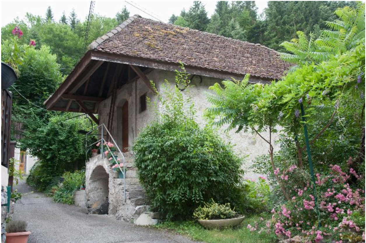
Vue d'ensemble du grenier depuis le chemin du four
