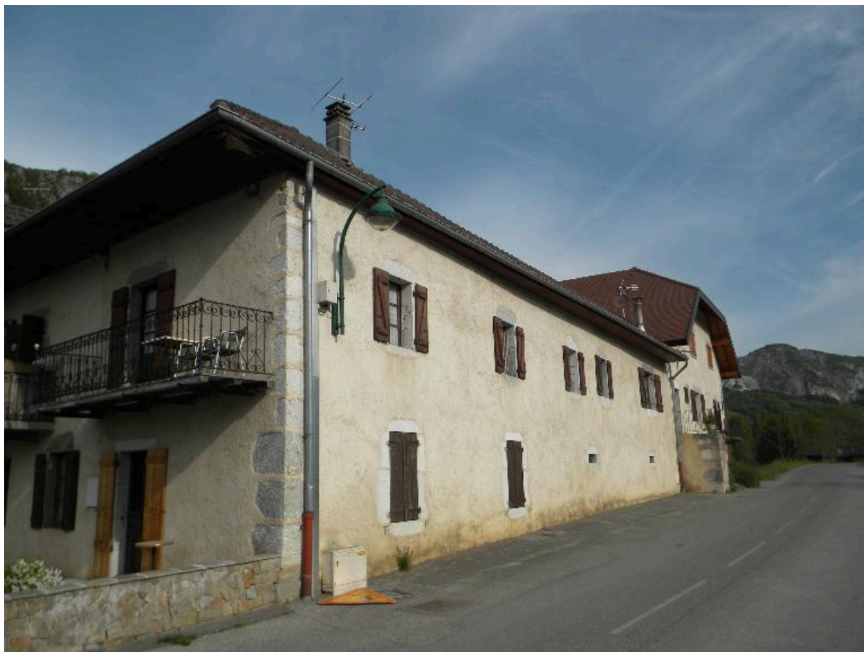
Vue de la façade est.
