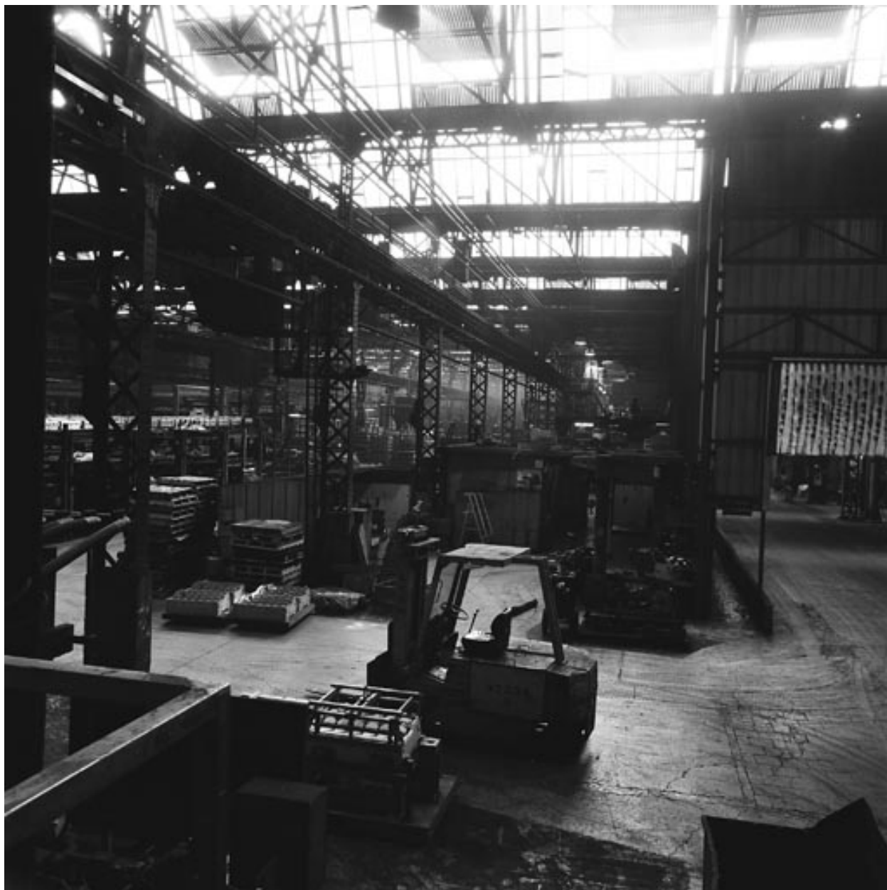
Ligne 17 : stockage des noyaux.
