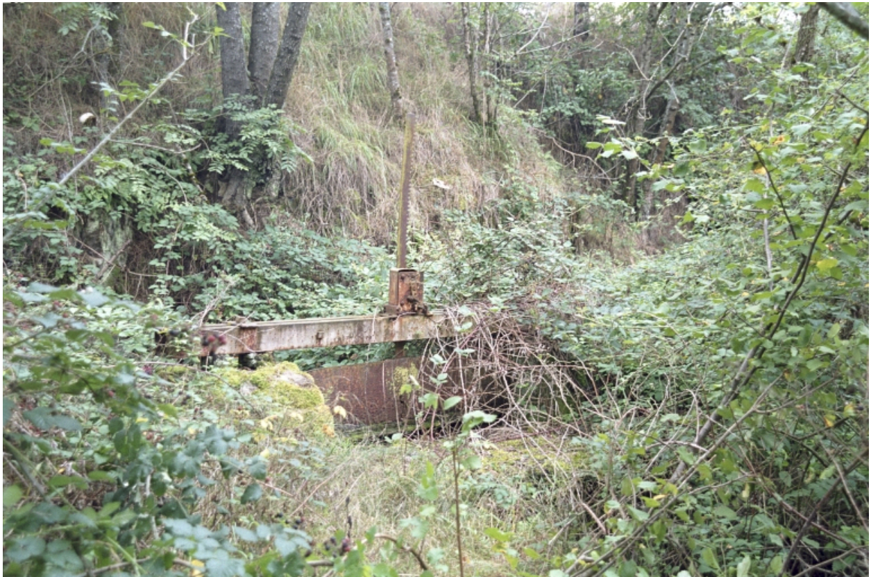
Détail d'une vanne métallique l'ancien bief d'alimentation en eau du moulin.
