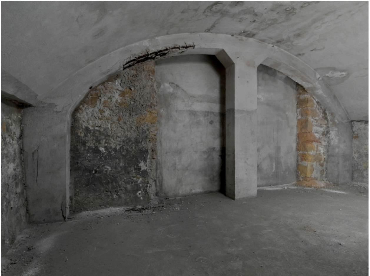
Cave du bâtiment B. Grande arcade est (la = 155 cm) : vestiges du passage vers le Rhône ?
