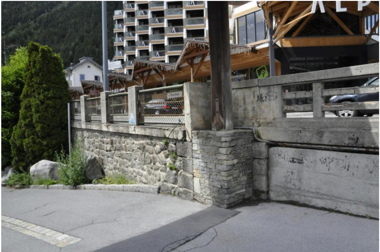
Détail du mur en retour de la face aval
