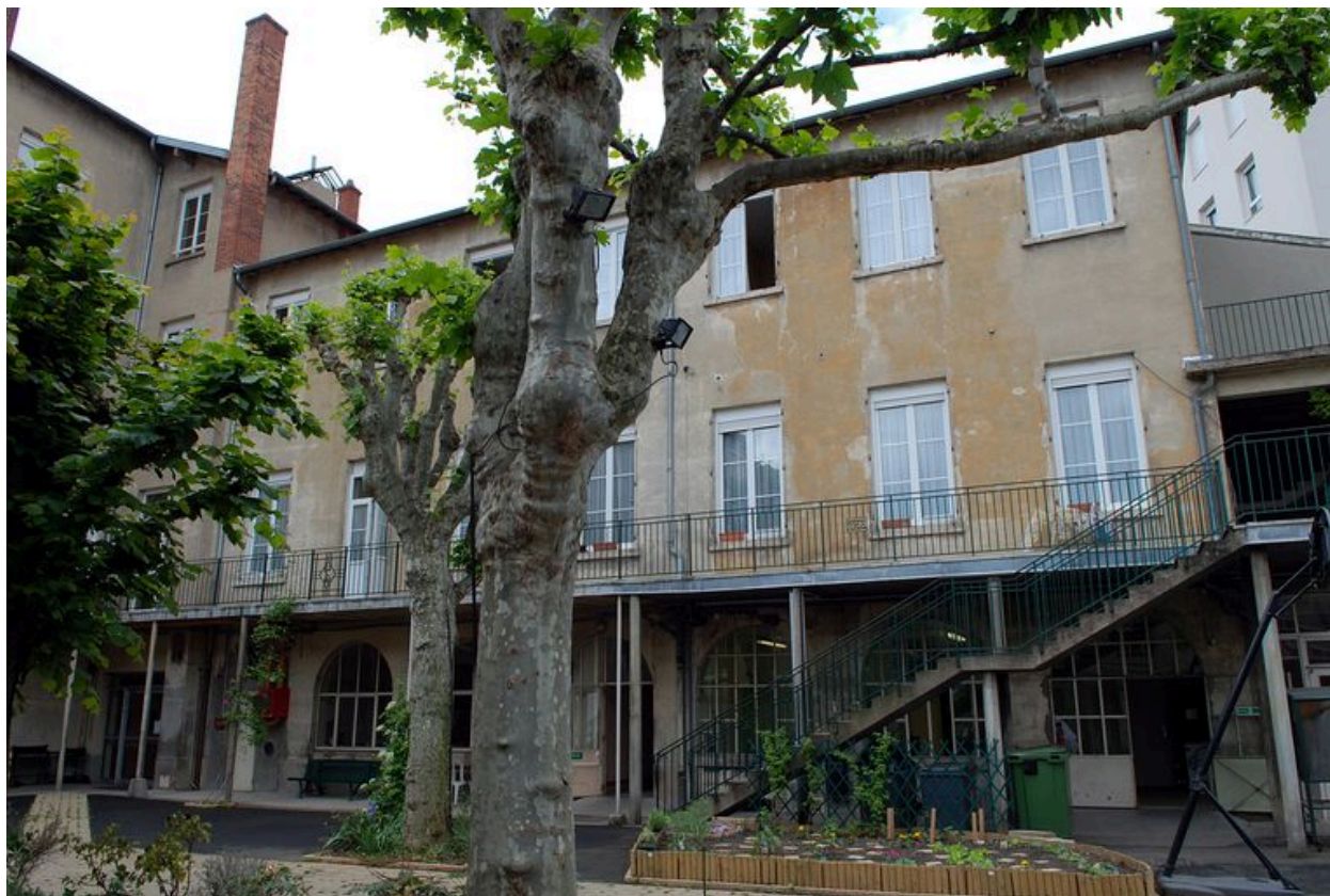
Corps de bâtiment perpendiculaire à la rue de la Claire : vue générale
