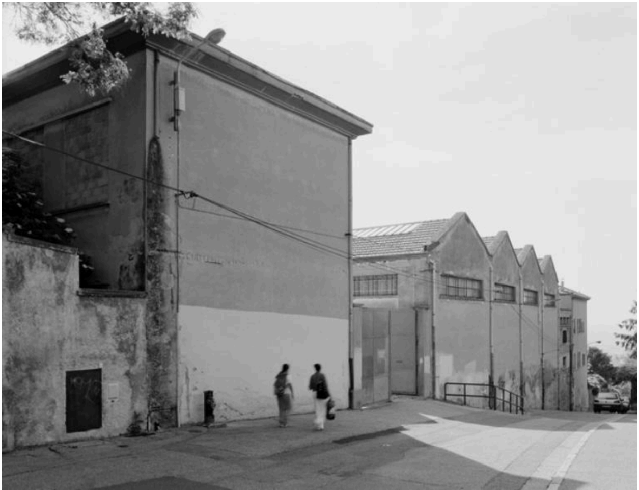
Vue d'ensemble ouest
