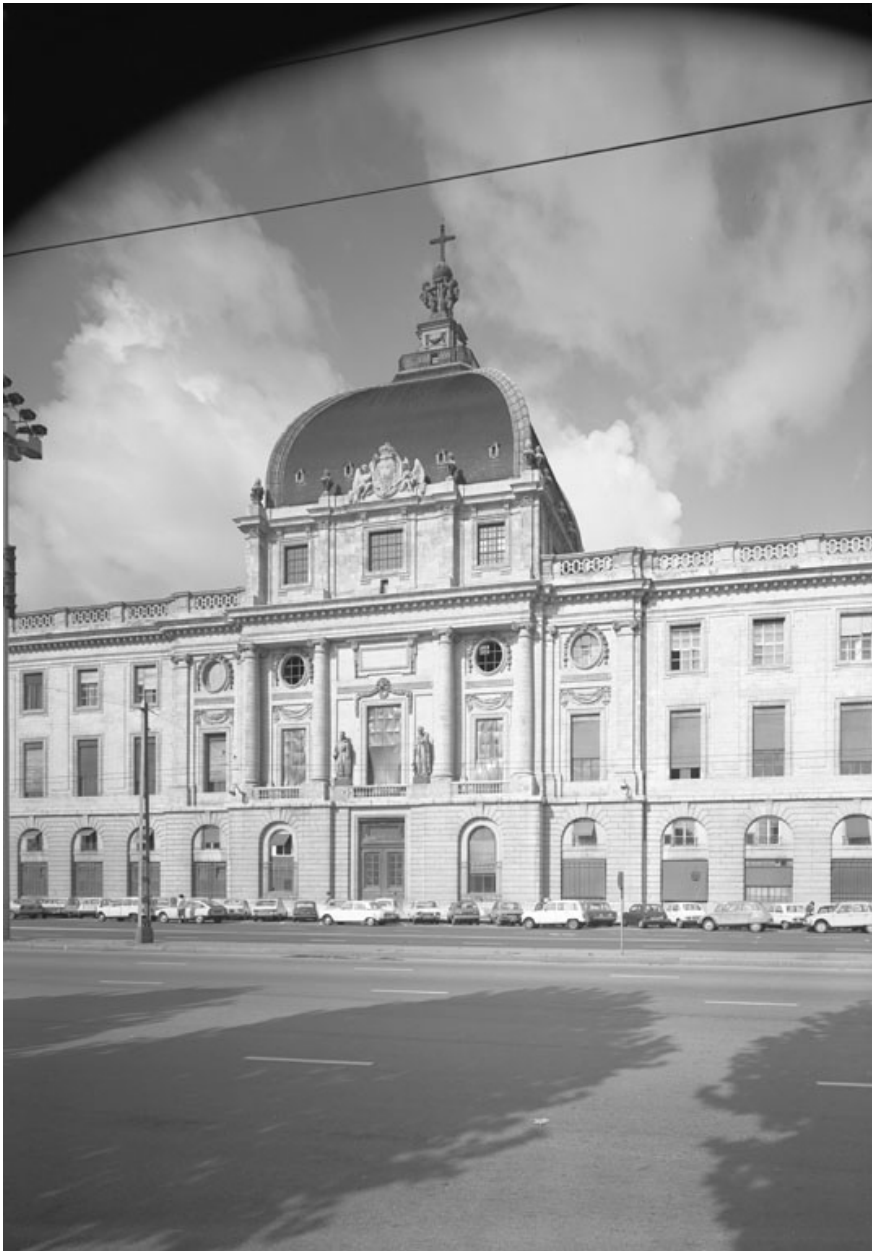
Elévation sur le quai du Rhône : vue du corps central couronné du dôme de XVIIIe siècle
