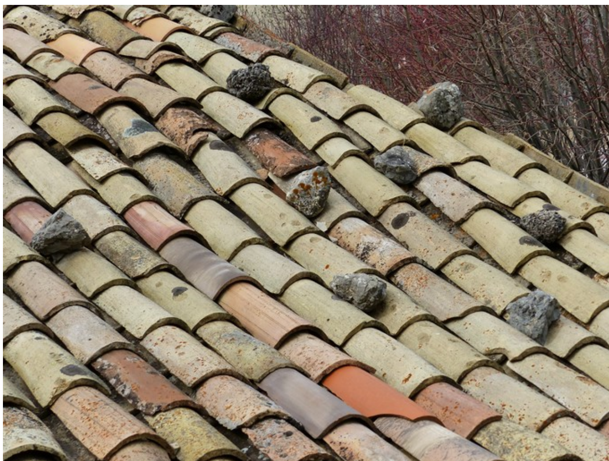
Couverture en tuile creuse.
