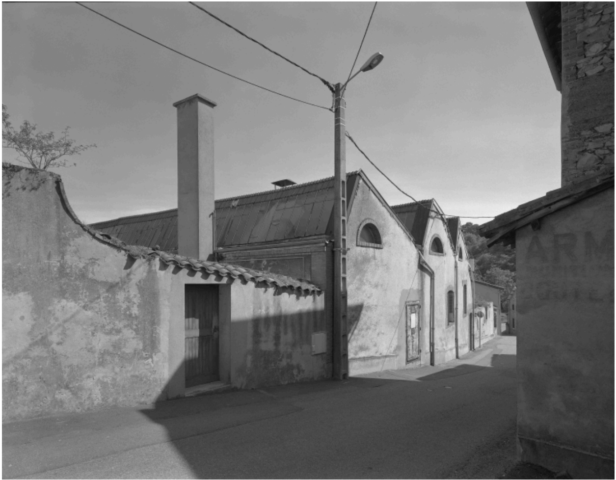
Vue générale des ateliers subsistants dans la rue Jean-Baptiste David, du nord.
