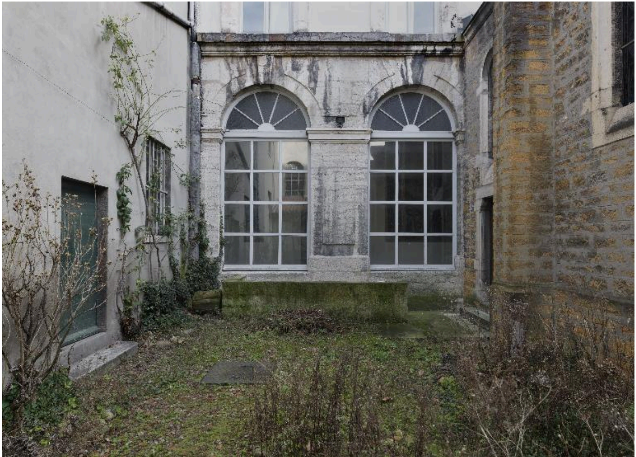
Prieuré, élévation ouest : détail depuis la cour du puits
