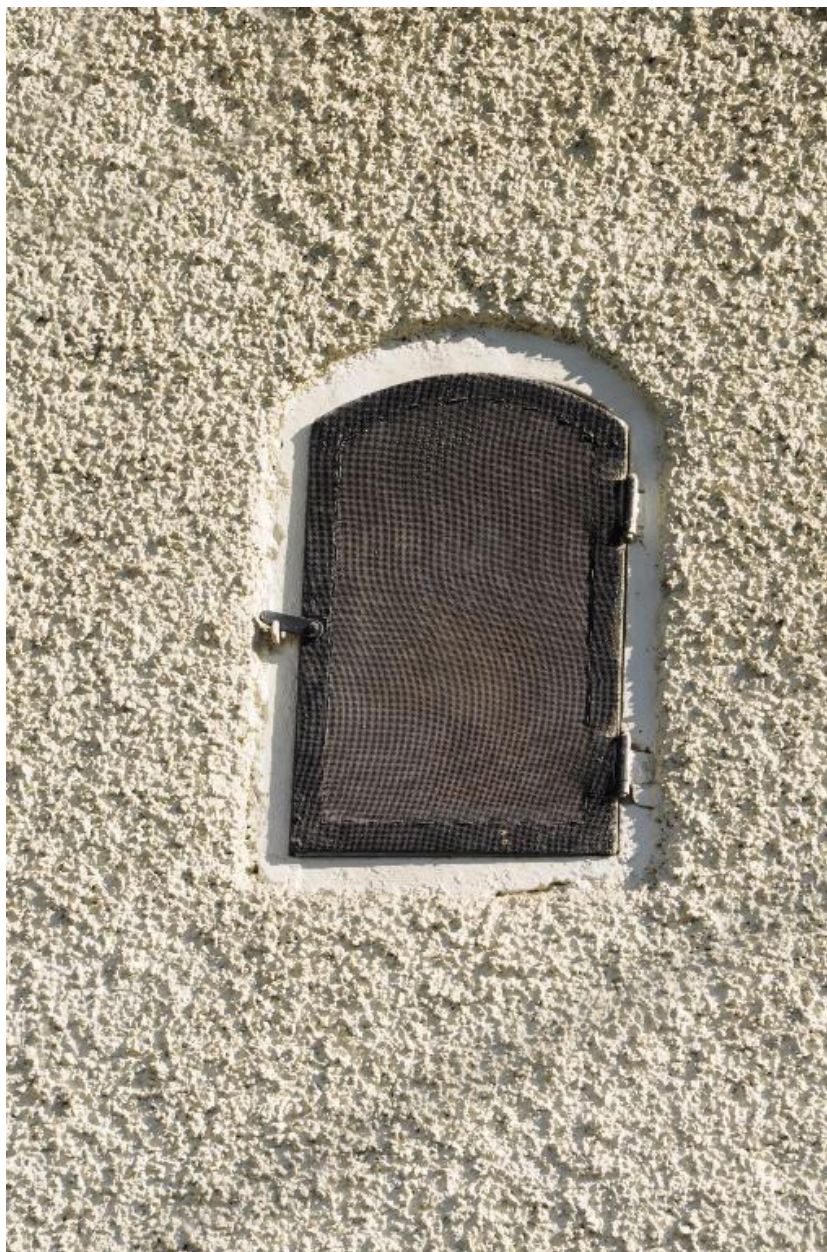
Niche mariale de l'élévation sud (angle sud-est)
