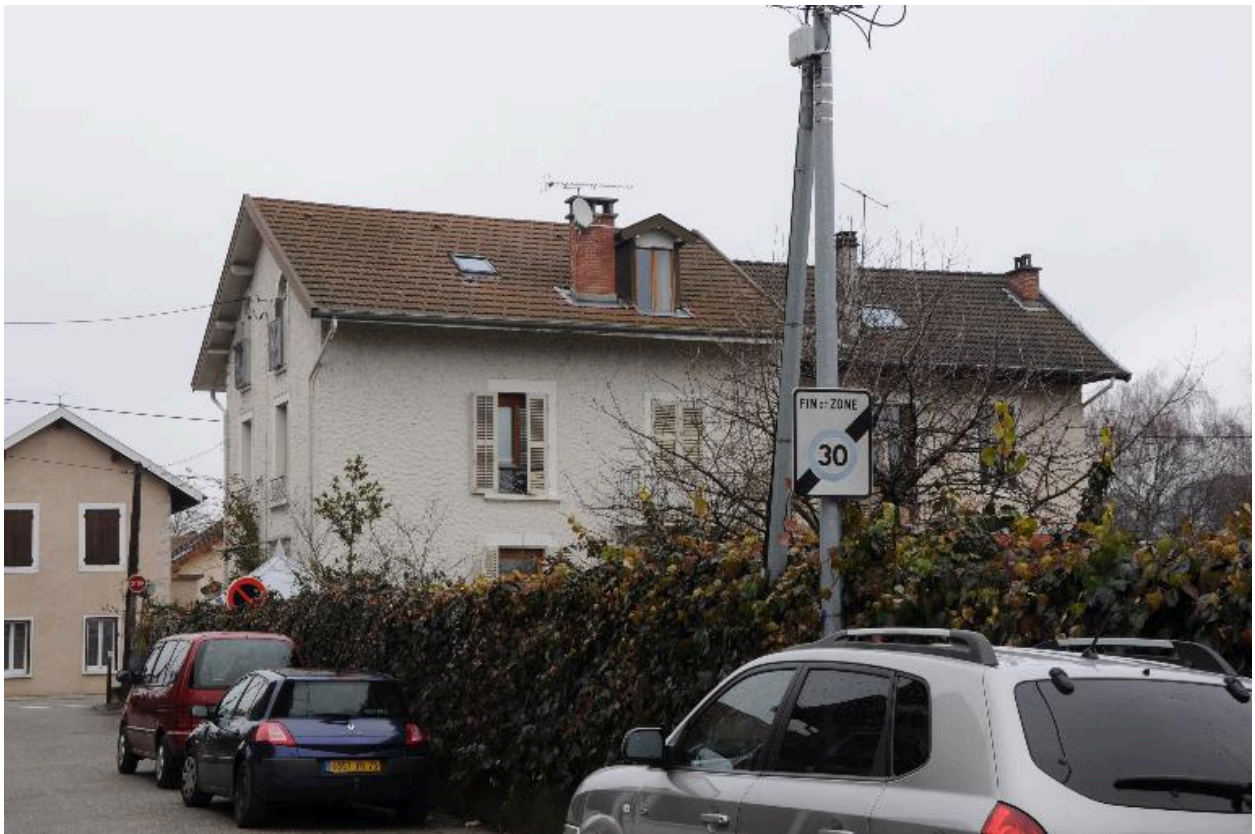
Vue depuis l'arrière
