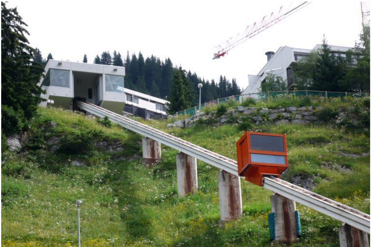
Arrivée de l'ascenseur à la gare
