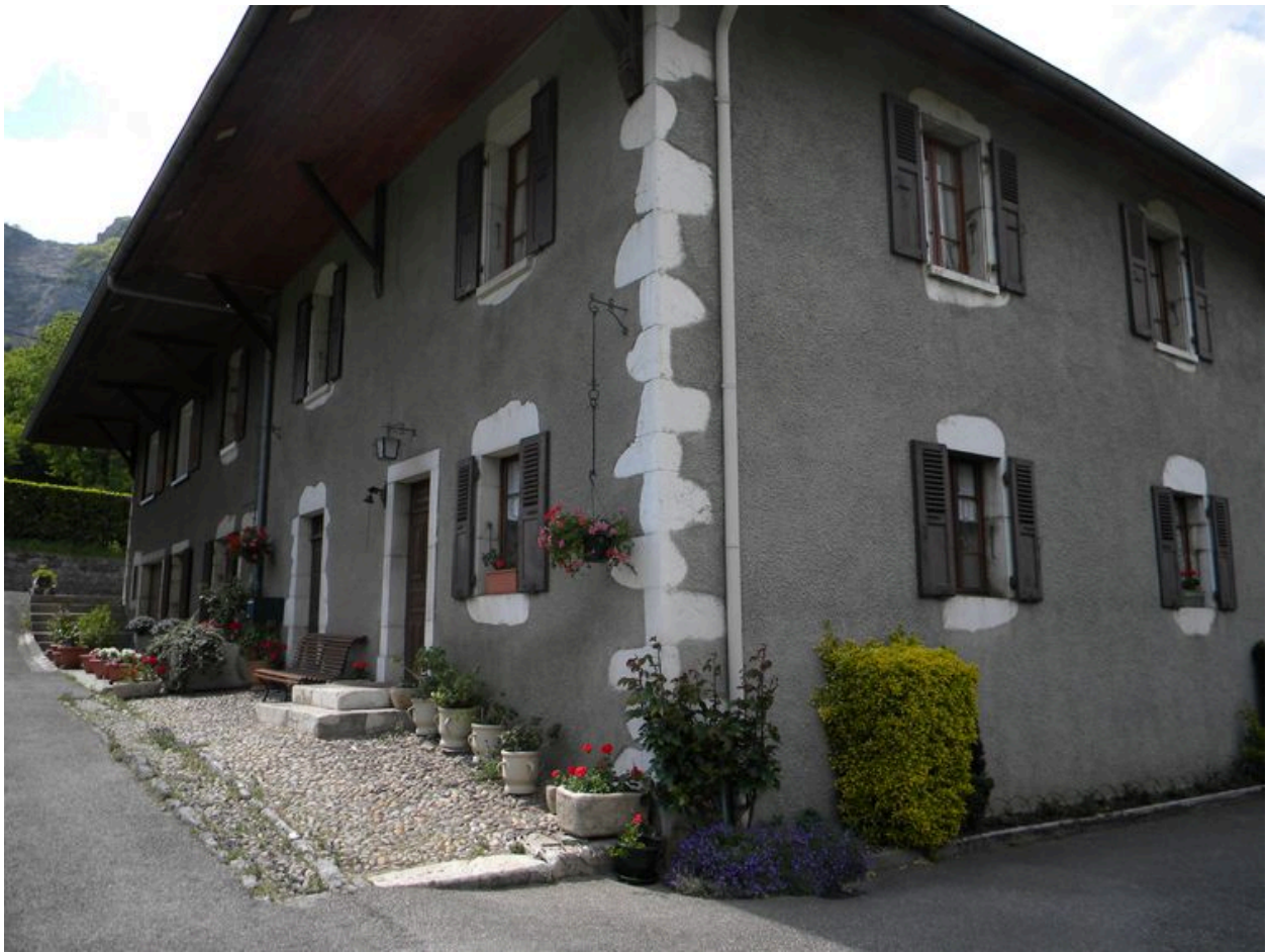
Vue de trois-quarts avec la calade devant la façade sud.
