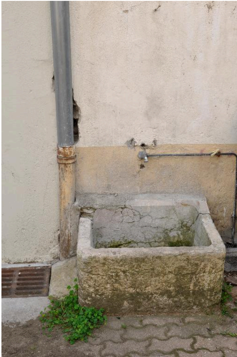
Fontaine adossée à l'immeuble sur rue, dans la cour
