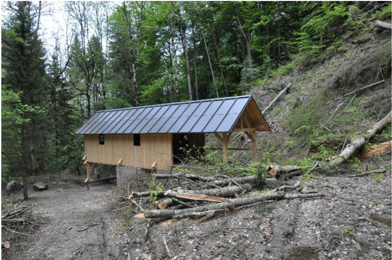
Vue du bâtiment après restauration, 2015.
