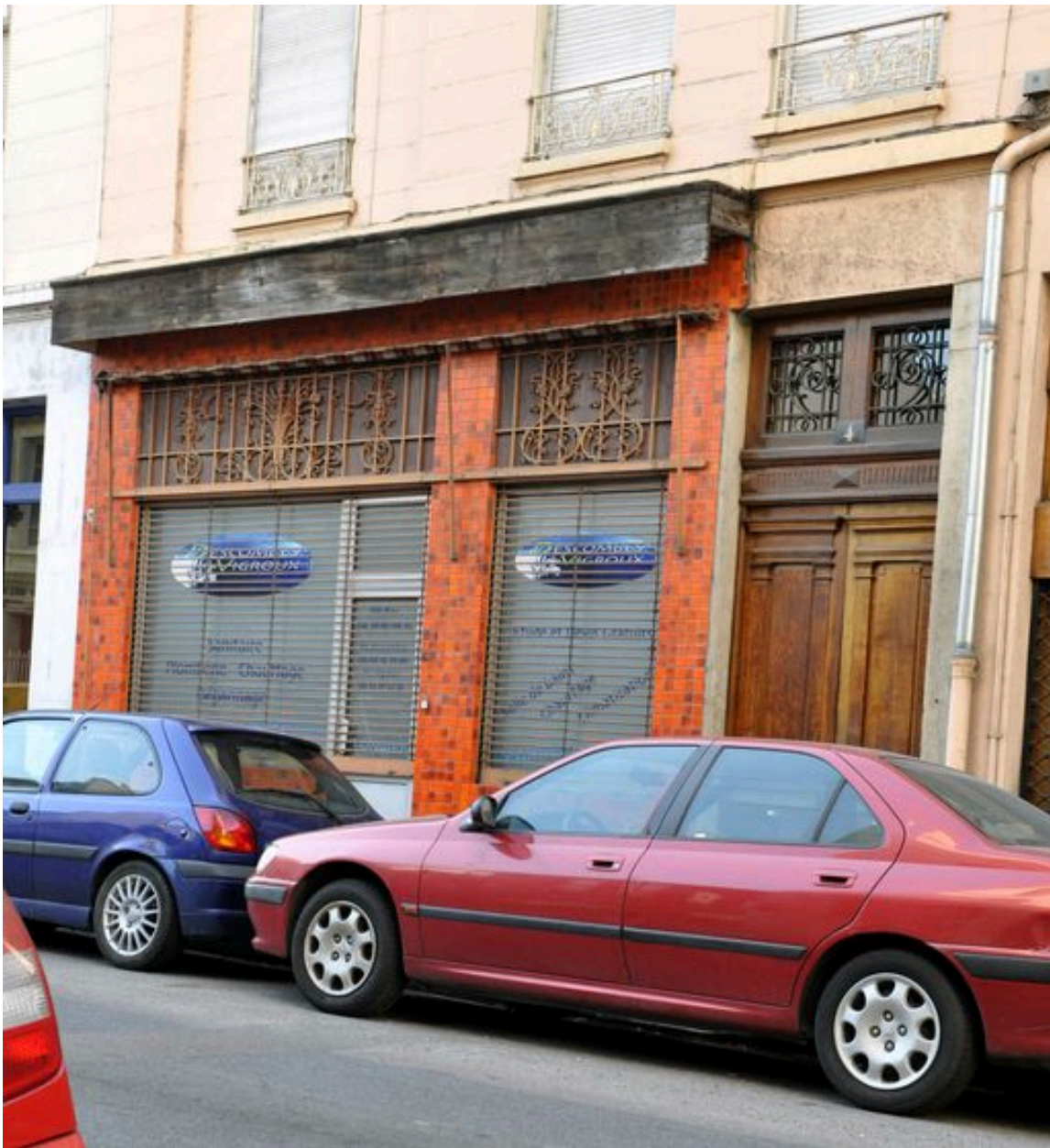
Vue du rez-de-chaussée
