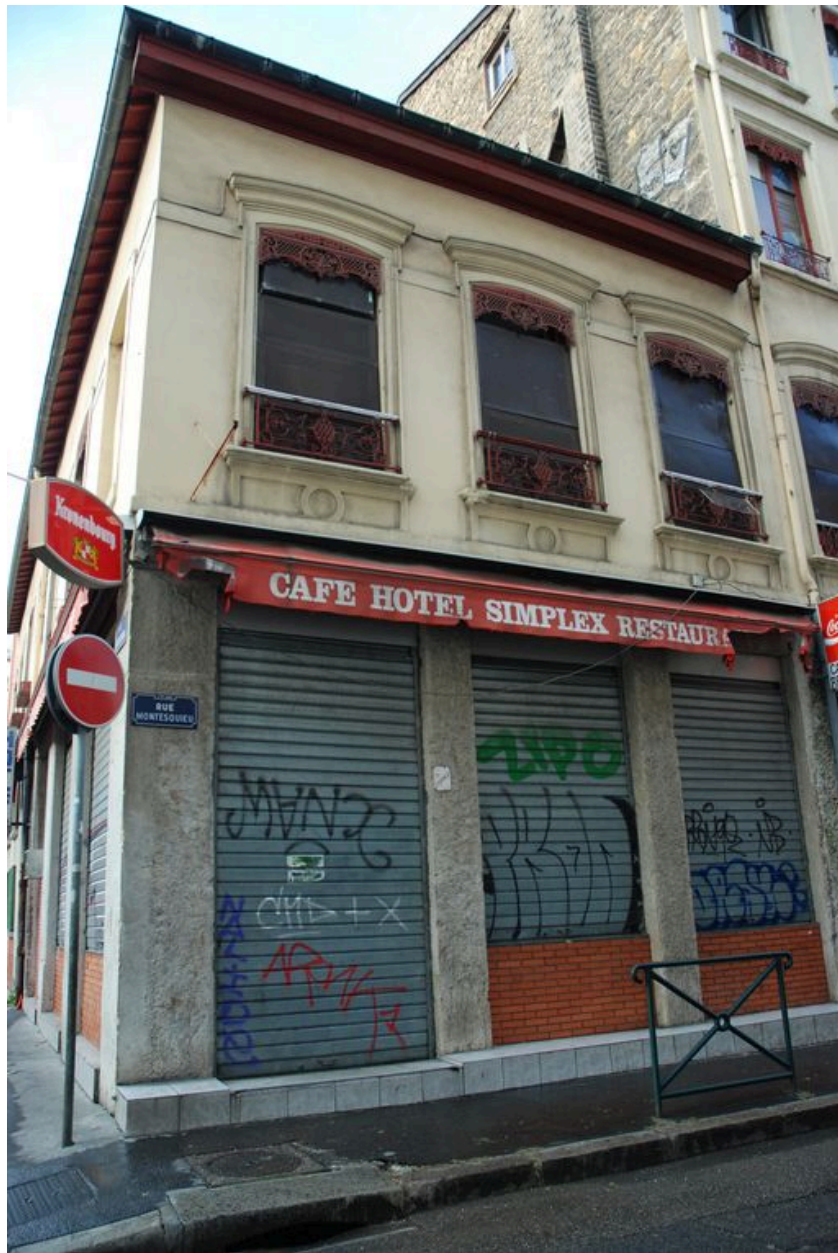
Bâtiment est, vu depuis la rue Montesquieu (état novembre 2012)
