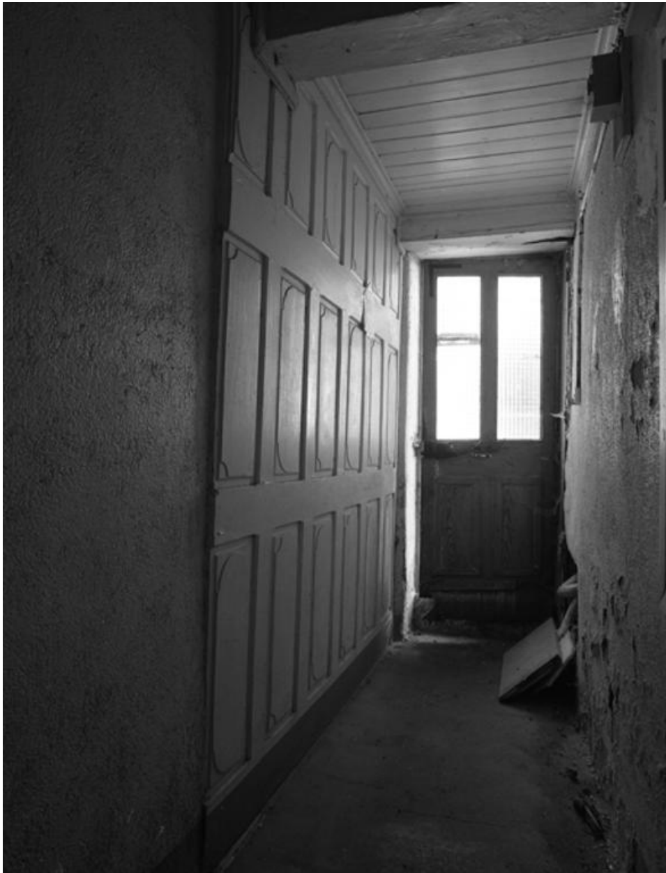
Couloir d'entrée et boiseries de la maison, avant travaux de reconstruction.
