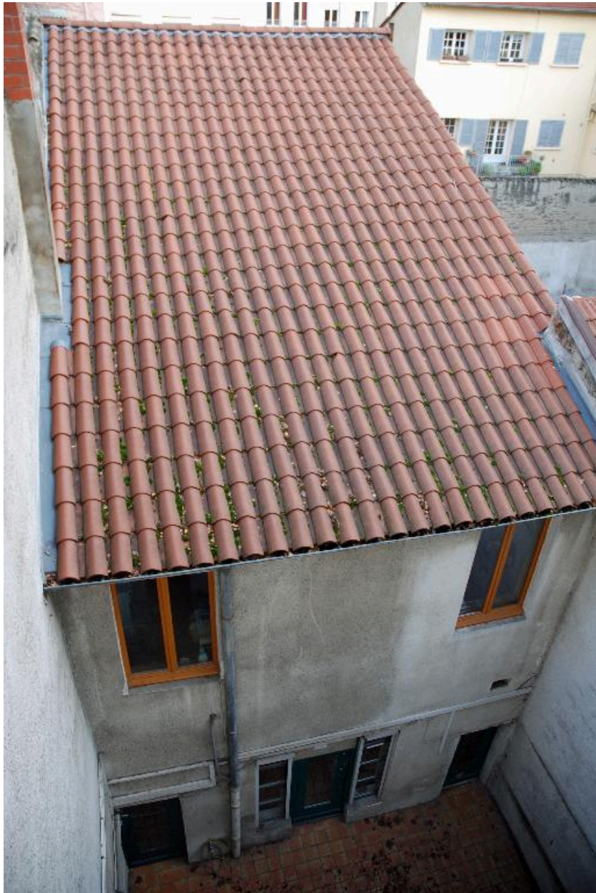
Bâtiment sur cour, vue plongeante
